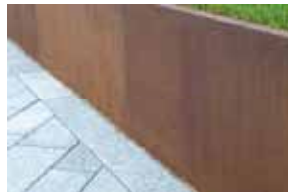
Im Bodenbereich gegen Bodenbelag (mit Splitt) laufen lassen
