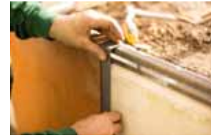
L-förmige Verbindungsleiste zwischen den Blechen einfügen
