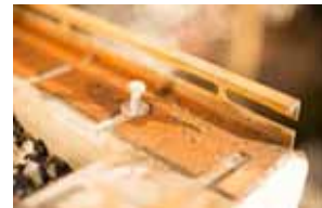
C-Schiene festschrauben
