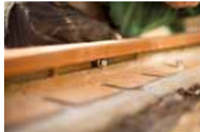
Bleche von hinten an den Gewindebolzen festschrauben
