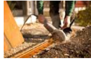
C-Schiene abschneiden
