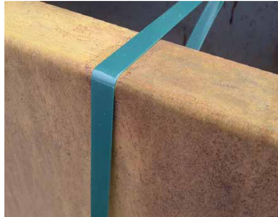
Für den Transport verwendete Spanngurte können Spuren auf der Oberfläche hinterlassen.
